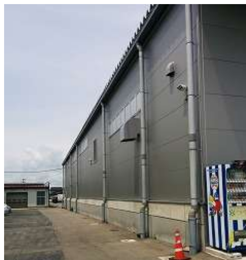
図1 精米工場の周囲（良好な状態）
