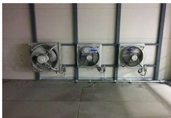
図3 精米工場内の換気扇（清潔な状態）
